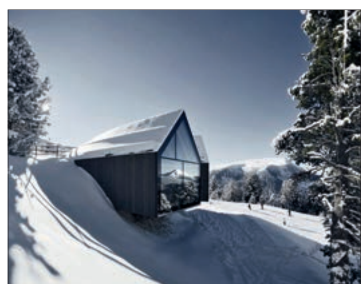
Hütte Oberholz, autark versorgt mit Erdwärme und erbaut mit vorwiegend einheimischen Hölzern.
