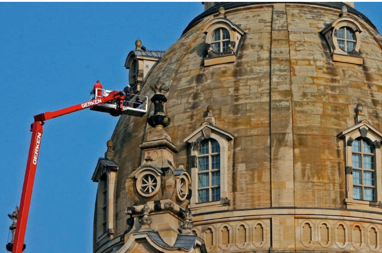
Mit Hilfe eines Hubsteigers wird die Außenfassade geprüft.
