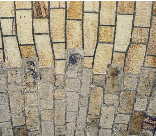
Die Aufmauerung der Unterkirche zeigt die Verzahnung der Altsteine der Vorgängerkirche und der neuen Steine des Gewölbes.
