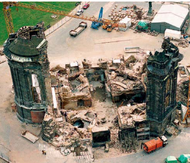
Die Unterkirche 1994 nach der archäologischen Enttrümmerung
