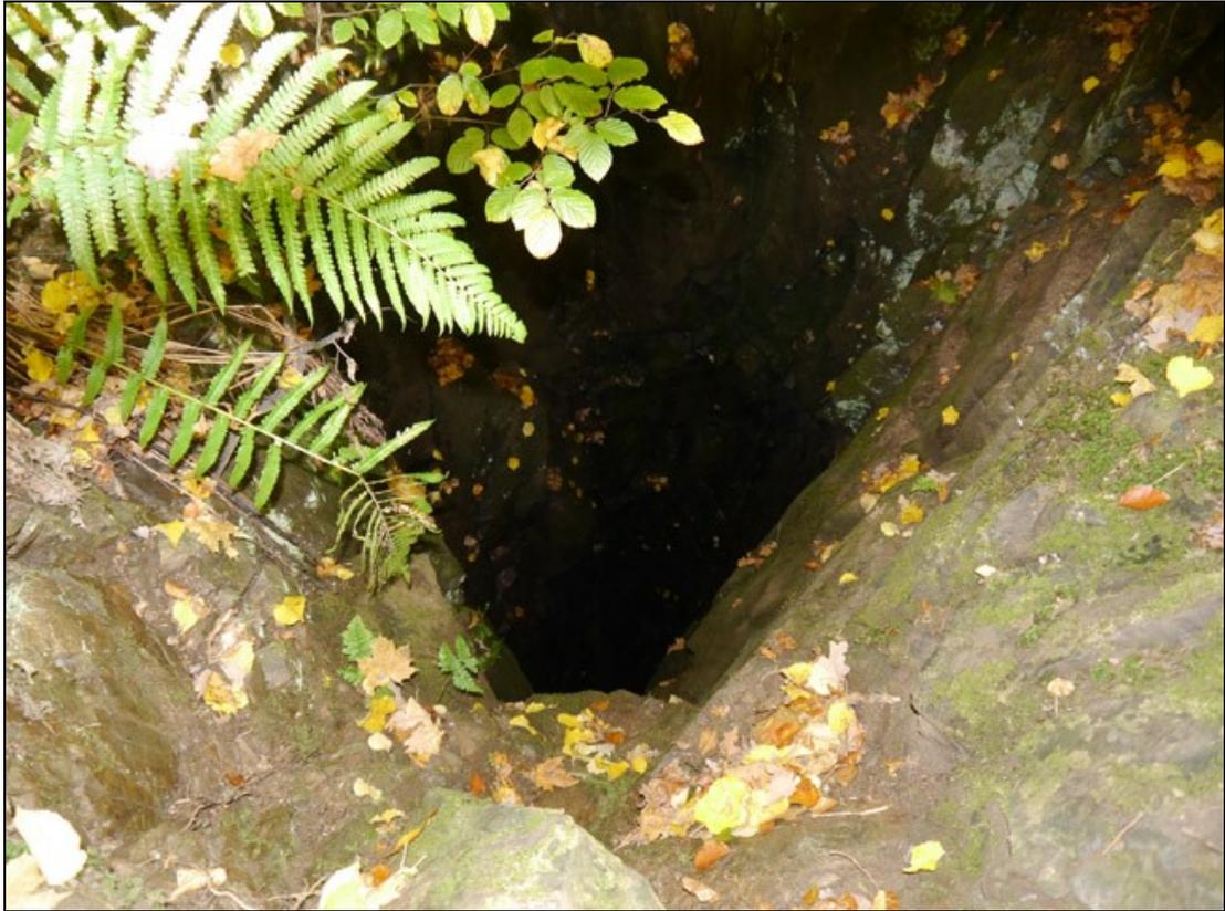
Die Konstruktion ist ziemlich neu und tragfähig und so können wir auch einmal hineinblicken. Es handelt sich um den zweiten Wetterschacht auf dem Karl Stolln: Im Profil von etwa 1,5 m x 2,5 m saiger abgeteuft.
