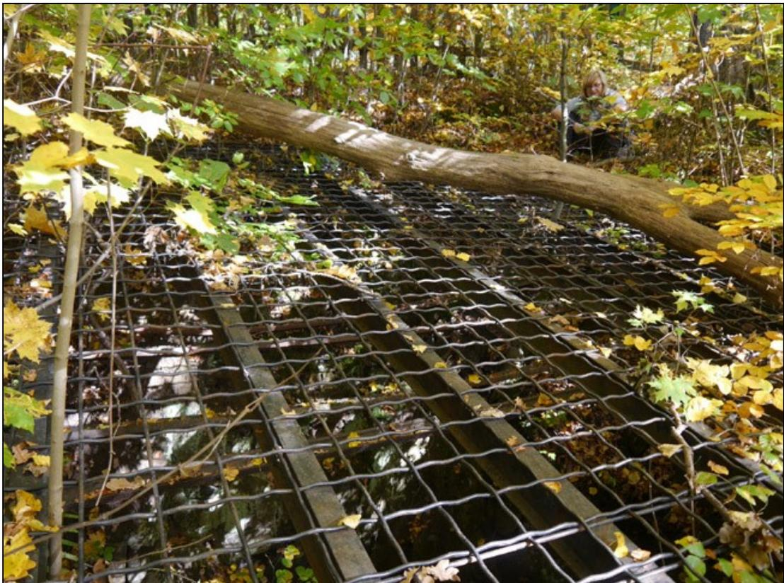
...und dahinter diesen Schachtdeckel aus Doppel- T- Trägern und Stahlgittermatten.
