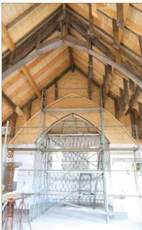
Das Besondere an der Holzkirche ist die sogenannte „Brettschichtbinderkonstruktion“ Foto: Zscheile
