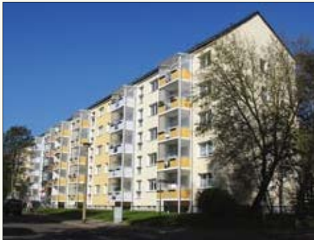
Die Wohnanlage „Agricolastraße“ bietet 57 Wohnungen für Betreutes Wohnen.
