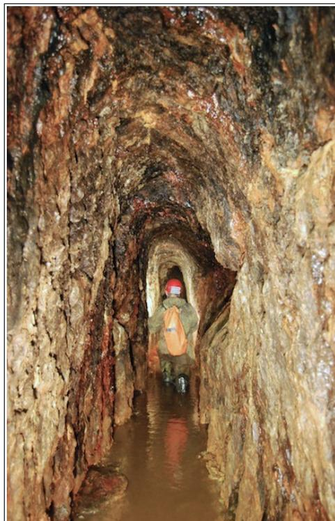
Die Anwendung der Bohr- und Schießarbeit ist hier trotz der Sinterbildung am Stollnprofil recht gut sichtbar. Schulze war seit 1837 Doppelhauer und durfte diese Gewinnungsart ausführen.
