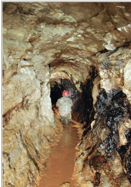
Das Profil des in den 1870er Jahren aufgefahrene Traktes ist nicht mittels Schlägel und Eisen nachgerissen. Man sieht deutlich die Spuren der Bohr- und Schießarbeit, die hier laut bergamtlicher Genehmigung mittels Dynamit erfolgte.
