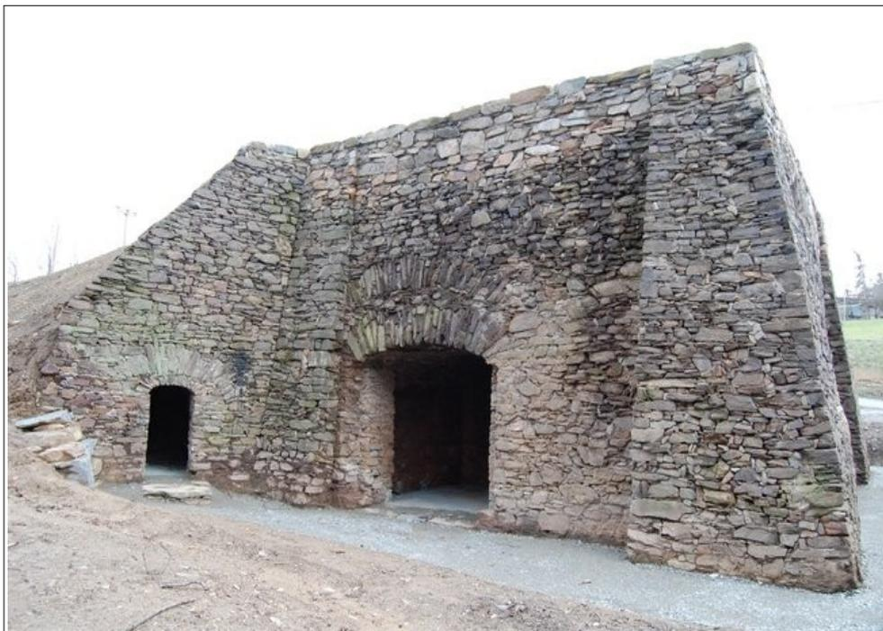
Nur als **Bildbeispiel** für einen auf Steinkohlenfeuerung arbeitenden Schneller- Ofen hier der mittlerweile sanierte Kalkofen im Ortsteil Blankenstein der Stadt Wilsdruff. Die Sanierungsarbeiten sind durch das Projekt [www.unbekannter-bergbau.de](http://www.unbekannter-bergbau.de) begleitet worden. Dieser auf Steinkohlenfeuerung ausgelegte Kalkbrennofen ist älter, als der in Auerswalde 1811 errichtete und hat nur einen Brennkessel.
