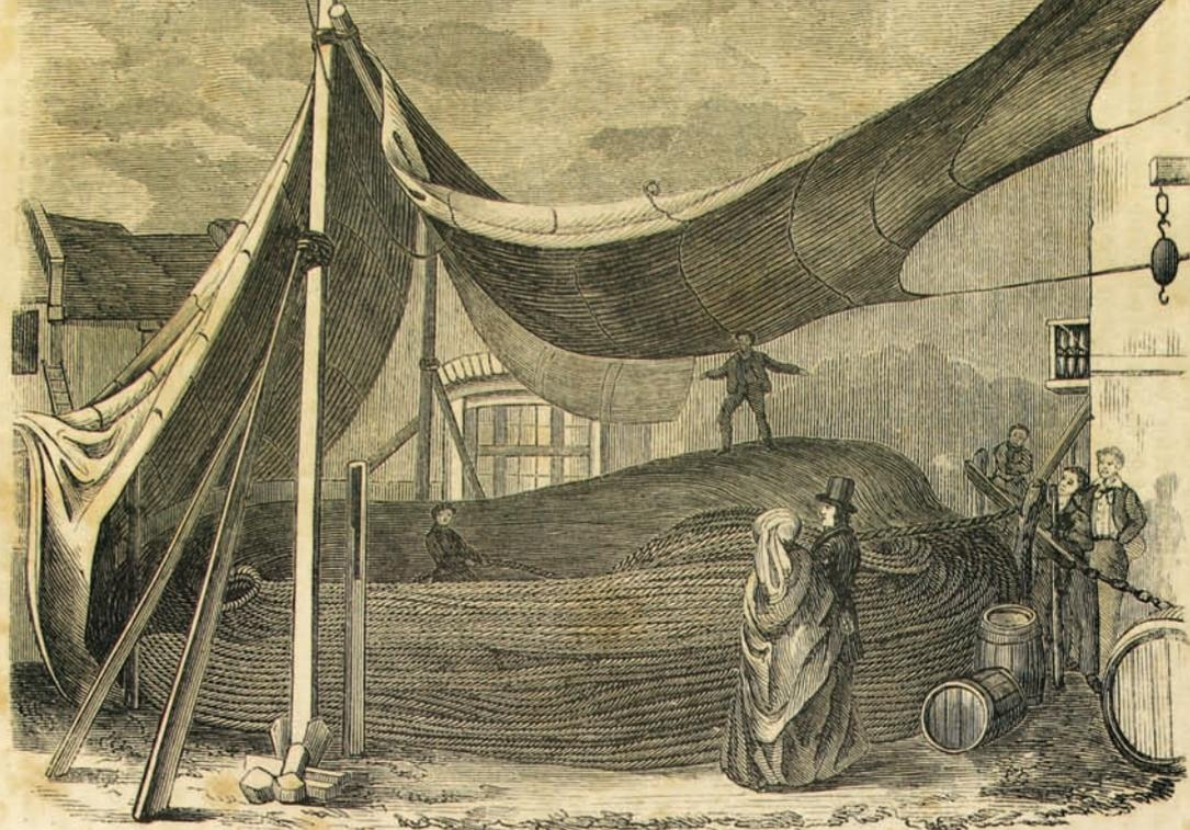
Das Kabeltau als Leitungsdraht des elektrischen Telegraphen zwischen Dover und Calais.
