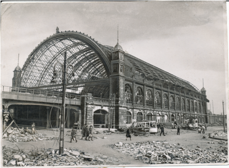
Abb. 5: Fotoabzug Wettiner Bahnhof (heute Hauptbahnhof Dresden-Mitte), 1946, Bernhard Braun. Das Stahlgerüst der Bahnhofshalle wurde 1953 abgerissen. (Stadtmuseum Dresden, Museen der Stadt Dresden, Ph 2012 00386)
