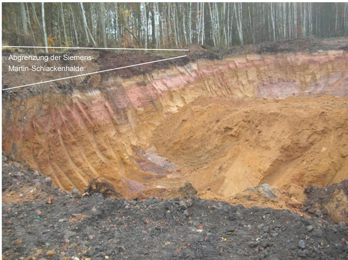
**Abbildung 38: Abgrenzung der Siemens-Martin-Schlackenhalde nach Nordosten mit Lehmgewinnung für Abdeckschichten zur Sanierung der Hüttengrundhalde**
