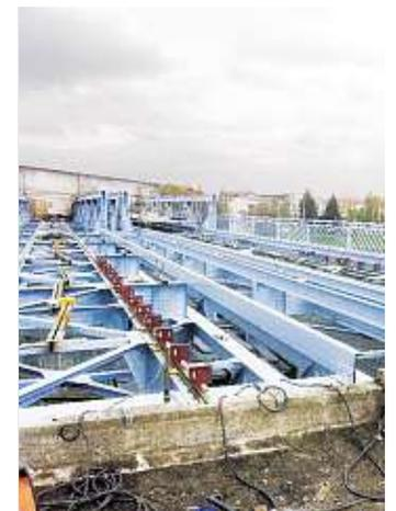
Die Korrosionsschutzarbeiten an der Elbebrücke sind teilweise bereits fertig.
