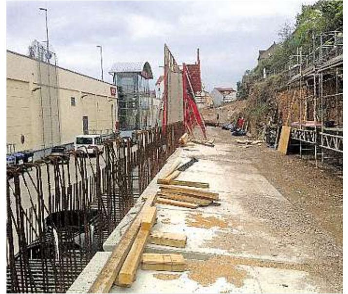
Die Wandbauteile an der Stützwand an den Neumarkt Arkaden werden je Block errichtet.
