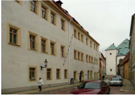
5: Oberbergamt in Freiberg
