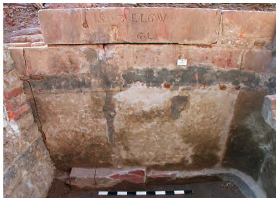
Abb. 3 Teil der Südwand mit Steinmetzzeichen, grauem Putz und Eisenklammern.
