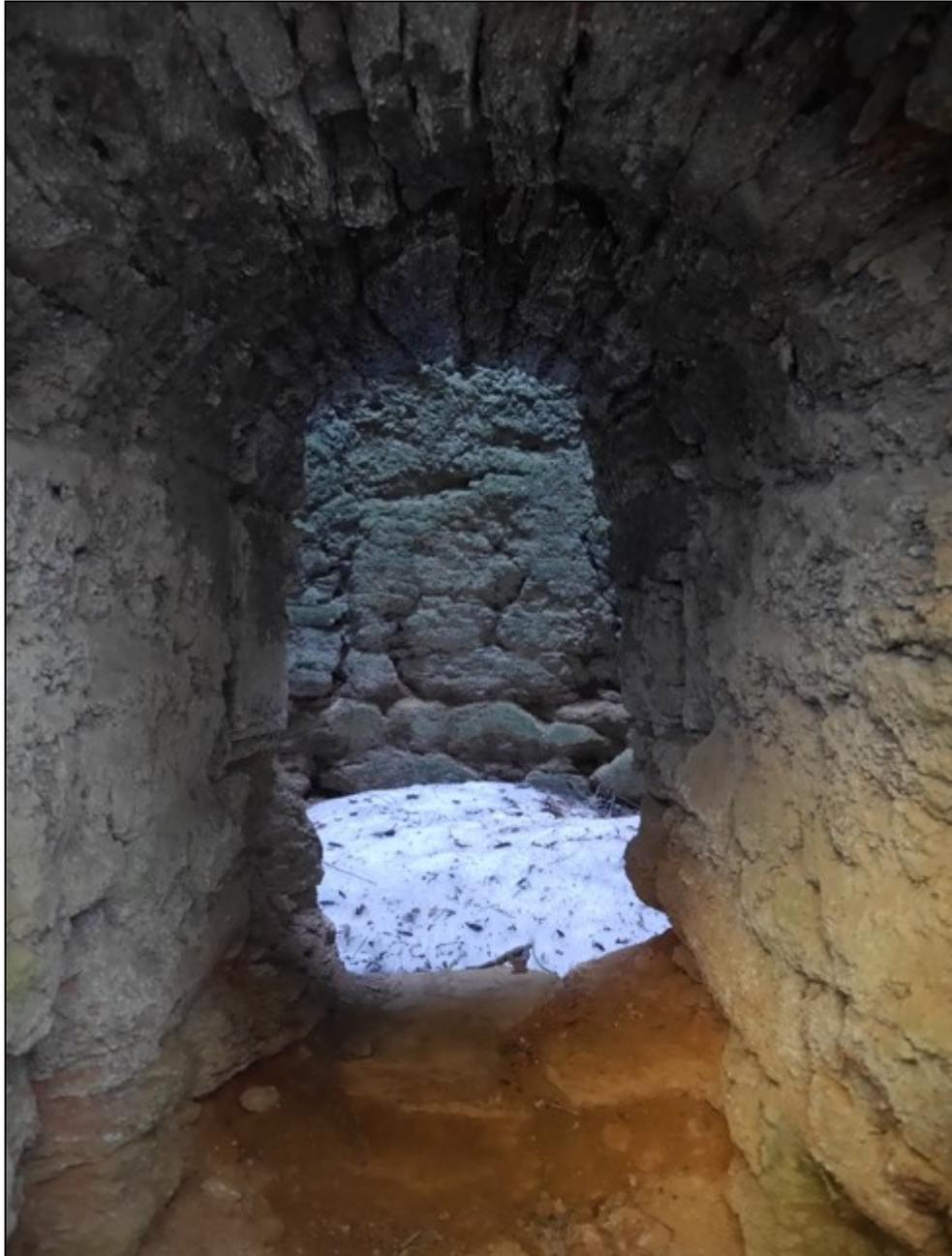
Von einem Rost ist auch von hier aus nichts mehr zu sehen. Der Brennschacht besitzt in dieser Höhe etwa 2 m lichten Durchmesser und ist bis auf Höhe der Feuerungen mit Schnee und Schutt gefüllt. Wahrscheinlich besaß der Brennraum eine pyramidenstumpfförmige Sohle, wie es bei den Öfen Hoffmann'scher Bauart typisch war.
