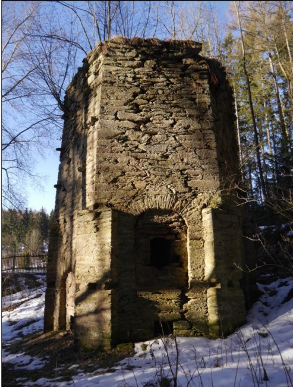
An der Rückseite lehnt der Ofen sich halbhoch ans Gelände an, so daß man dort einen Zugang zu den Feuerungen leicht einrichten konnte. Im Foto ist auch unterhalb des Kalkabzuges links eine Öffnung zu sehen, über die man wohl Kalkmehl getrennt vom Stückkalk ausziehen konnte.
