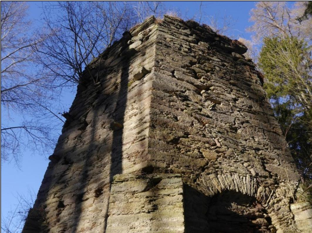
Und ein Blick nach oben: Auf den auskragenden Steinen haben sicher die Balken des Dachs der Einhausung aufgelegt. Ungewöhnlich sind die zusätzlichen Stützpfiler, die man den sechs Ecken noch vorgesetzt hat; wohl deshalb, weil er schlanker gebaut ist, als die größeren Brennöfen des Lengfelder fiskalischen Kalkwerkes und weil er nicht wie diese ummauert wurde, sondern die Einhausung aus Holz errichtet war.
