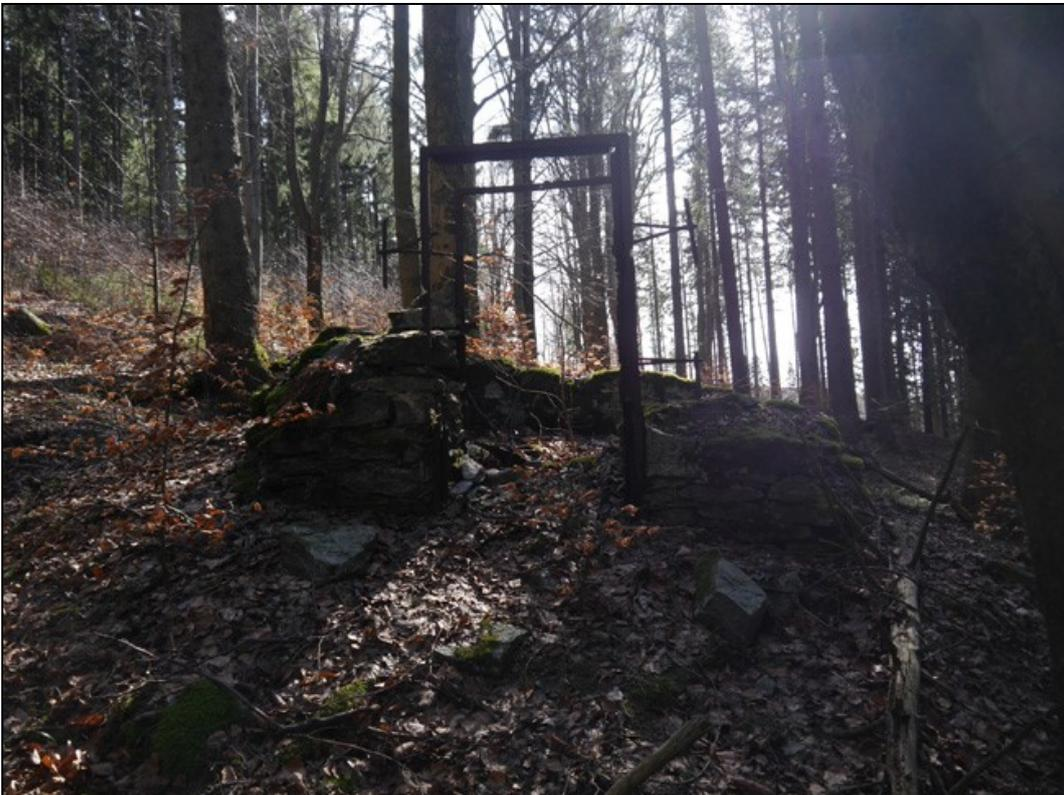
Die Grundfläche lag bei kaum mehr als 3 x 3 m. Der doppelte eiserne Türrahmen war mit V-förmigen Ankern im dicken Mauerwerk gesichert. Nach Bergverwalter Seemann's Bericht war es den Vorschriften entsprechend errichtet.
