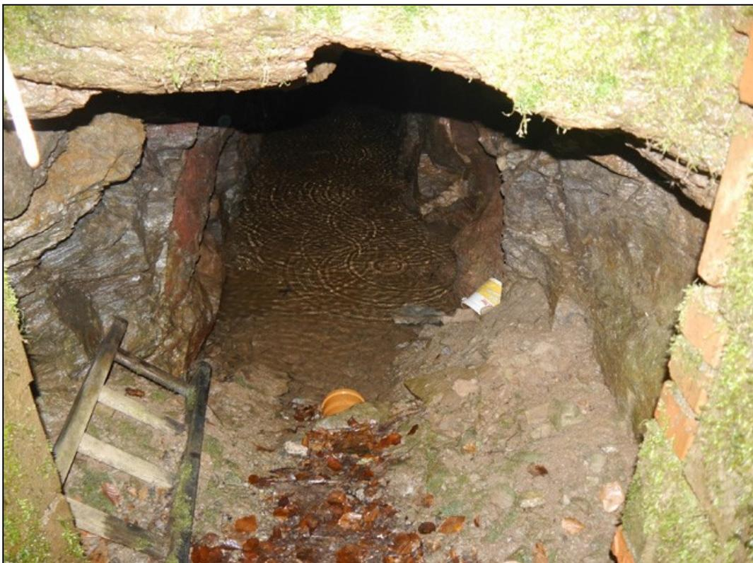
Mit der Kamera durch´s Gitter fotografiert: Er steht im festen Glimmerschiefer und führt nach wie vor das Wasser aus den Bauen unterhalb der Tagebausohle ab.
