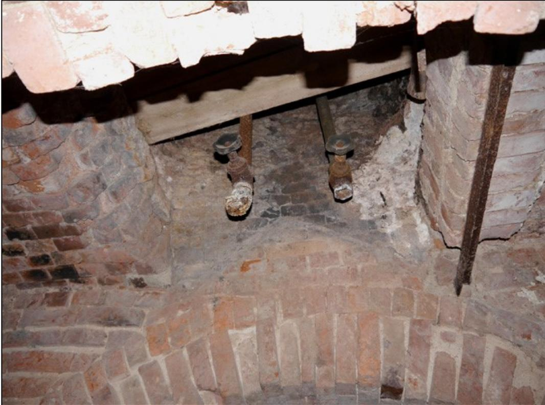
Am Ende des kurzen Zugangs steht man unter dem Brennschacht. Hier befand sich ursprünglich der Aschefall unter dem Rost. In den 1930er Jahren wurde in den Brennschacht ein eiserner „Kochkessel“ eingebaut, in dem die damaligen Pächter das Brennmaterial für Feueranzünder zusammenrührten. Hier unten konnte man dann das verflüssigte Gemisch über die Rohrleitungen abziehen und in Formen gießen. Aufnahme: M. Och, Meerane.
