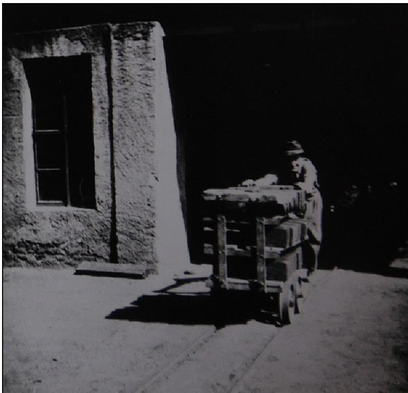
Transport der Ziegelrohlinge zum Trockenraum über dem Ziegeleibrennofen, alles erfolgte mit Muskelkraft. Bildquelle: wie oben.
