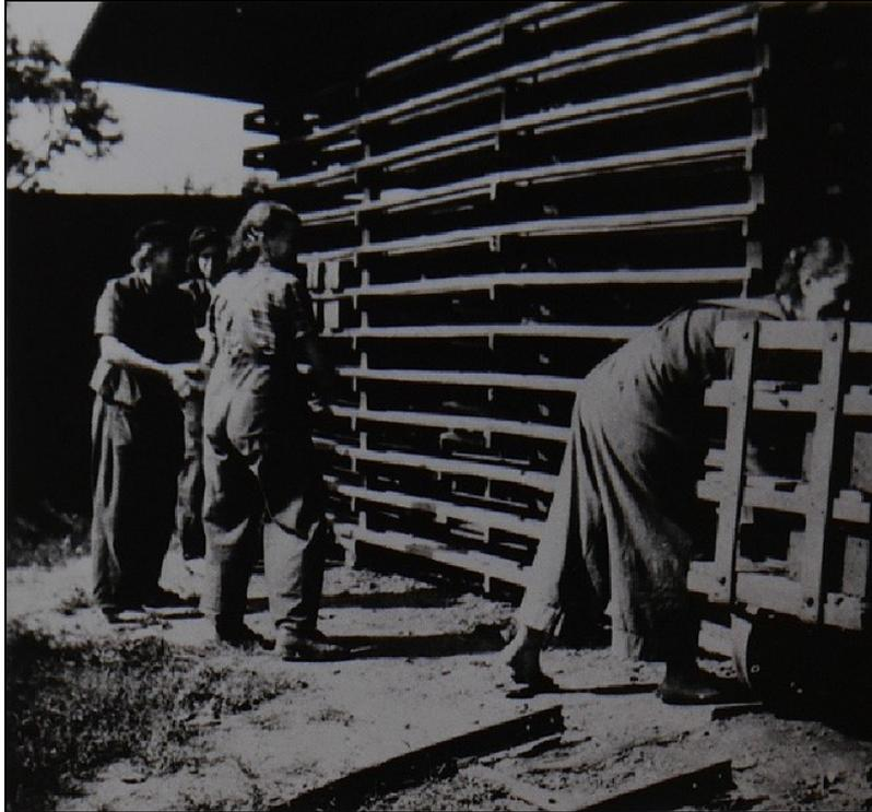
Aufschichten der Ziegelrohlinge zum Trocknen und Verladung der getrockneten Rohlinge für den Transport zum Brennofen; diese Arbeiten verrichteten häufig auch Frauen. Bildquelle: Fa. Bachmann & Söhne K. G., aus dem Nachlaß von **Christine Bachmann**, Gattin des letzten Eigentümers **Ehrhard Bachmann**, jetzt Sammlung M. Och, Meerane.
