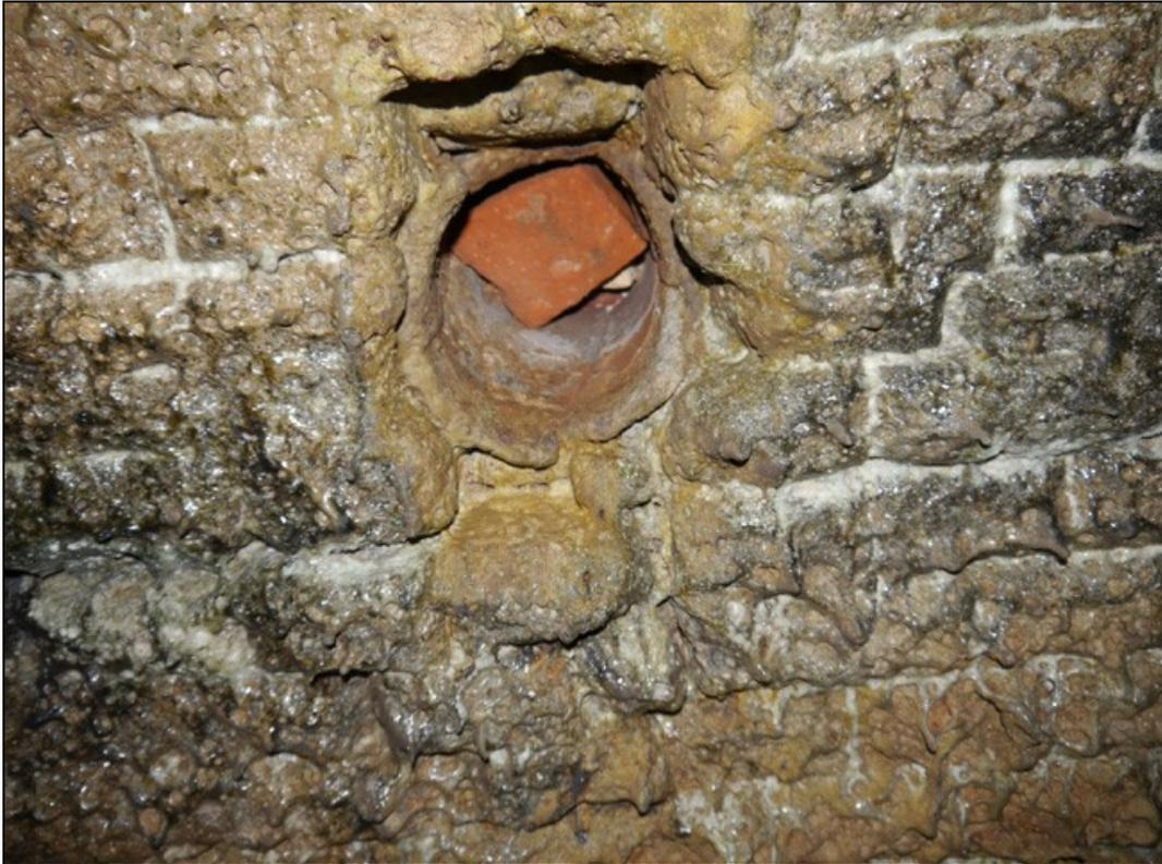
Eine kleinere, mit einem Tonrohr ausgebaute und mit einem Ziegel verstopfte Öffnung in der Gewölbedecke, die sicherlich zum Frischluftkanal geführt hat. Aufnahme: M. Och, Meerane.
