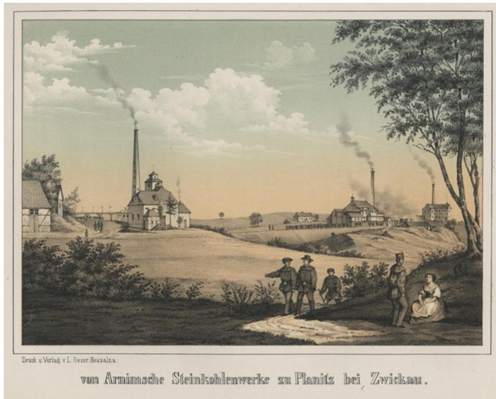
Diese kolorierte Lithographie aus dem Jahr 1856 zeigt die Übertageanlagen der von Arnim'schen Steinkohlenwerke in Planitz. Neben dem Anschlußgleisen im Hintergrund sind vermutlich der Himmelfahrt Schacht und (ganz rechts) der (alte) Alexanderschacht zu sehen, links im Vordergrund der Kunstschacht.
