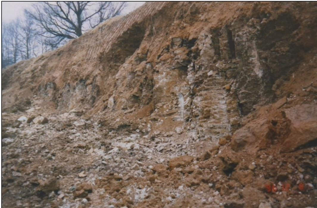
Der Verlegegraben des Abwasserkanals im Jahr 1996: Im Stoß steht unter einer Auflage aus Lößlehm und Oberboden der Plattendolomit an. Foto: M. Och.
