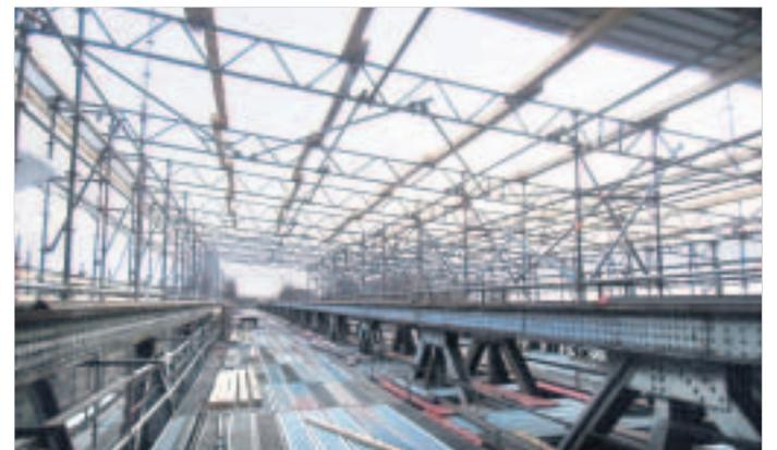
Um den Korrosionsschutz aufzubringen, wurde die Elbebrücke komplett eingehaust.
