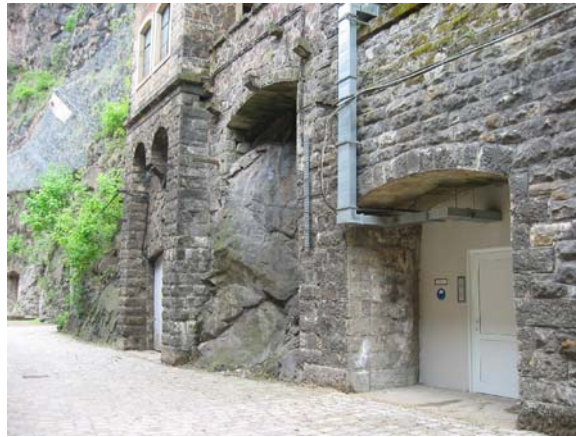
Abbildung 3: Eingang zum Stolln mit dem Untertagemesslabor „Felsenkeller“
