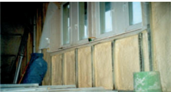
Sprühschaumbeschichtungen der Firma ipurtec aus Strehla werden nicht nur in Wohnhäusern eingesetzt. PUR-Dämmung ist resistent gegen Schimmel. Fast jeder Untergrund eignet sich. Fugen gibt es nicht.
