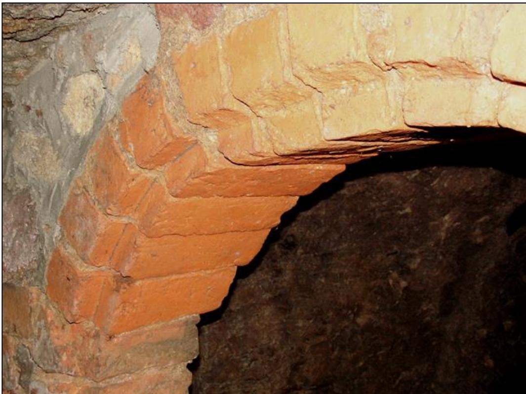
Für diesen Rahmen wurden nämlich spezielle „Formsteine“ gebrannt, in die das Türblatt hineinpaßte, so daß es nicht ausgehebelt werden konnte. Diebstahlsicherung früherer Zeiten...
