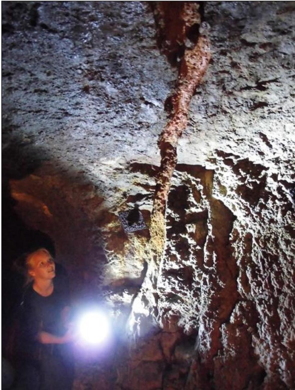
Dann entdecken wir quer durch Stoß und Firste eine mehrere Zentimeter breite Lettenkluff. Weil sie aber an den Stößen aussetzt, handelt es sich bei dem roten Material wahrscheinlich um von Übertage eingeschwemmten Lehm.
