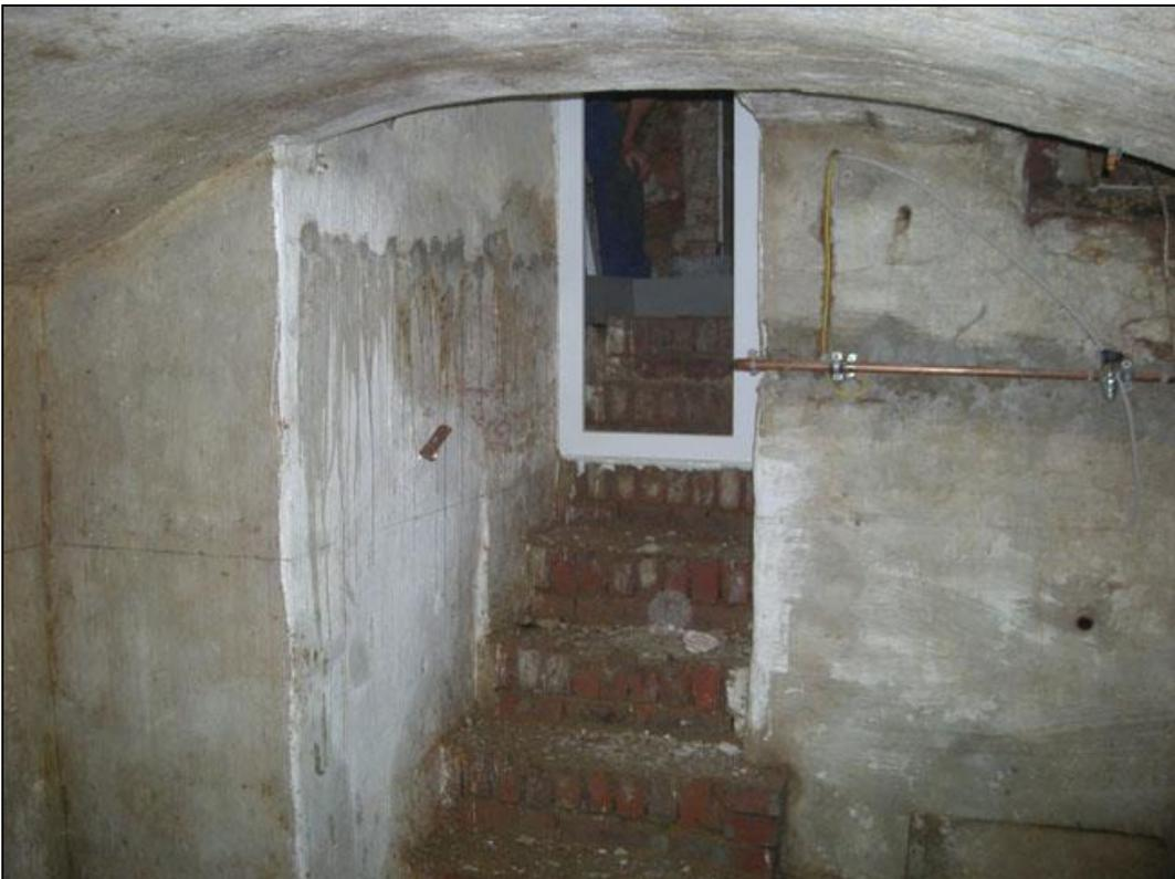
Von innen sieht man den steilen Treppenzugang und ein flaches Tonnengewölbe als Ausbau. Alles wurde in diesem Fall aus Ziegelmauerwerk errichtet.
