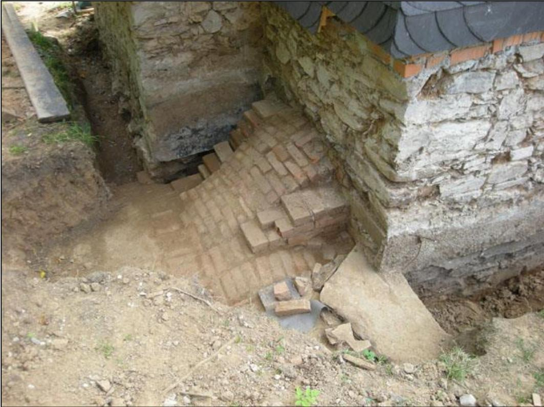
Beispiel eines Tiefkellers: Während der Sanierung des Bergamtshauses in Wolkenburg wurde der Zugang zu dem in das Gelände außerhalb des Gebäudegrundrisses eingetieften Keller von oben sichtbar.
