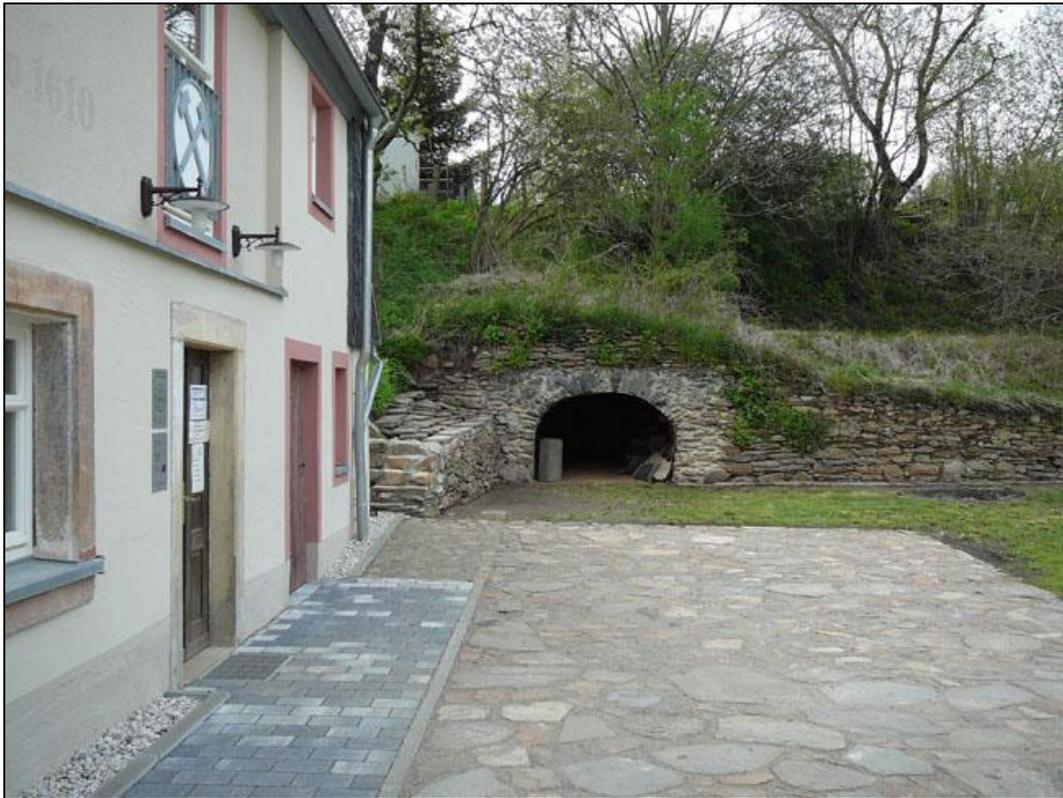
Zu ebener Erde gelangte man dagegen (ursprünglich durch die heute hier nicht mehr vorhandene Scheune hindurch) in diesen Bergkeller, der quasi „geradeaus“ von der Talsohle aus in den Hang des Hügels am Bergamtshaus in Wolkenburg gegraben wurde. Er ist mit einem Tonnengewölbe aus Naturstein ausgebaut.
