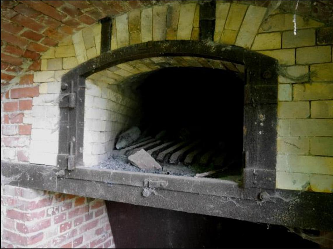
Der Brennschacht und die Abzüge sind mit Schamottesteinen ausgekleidet.
