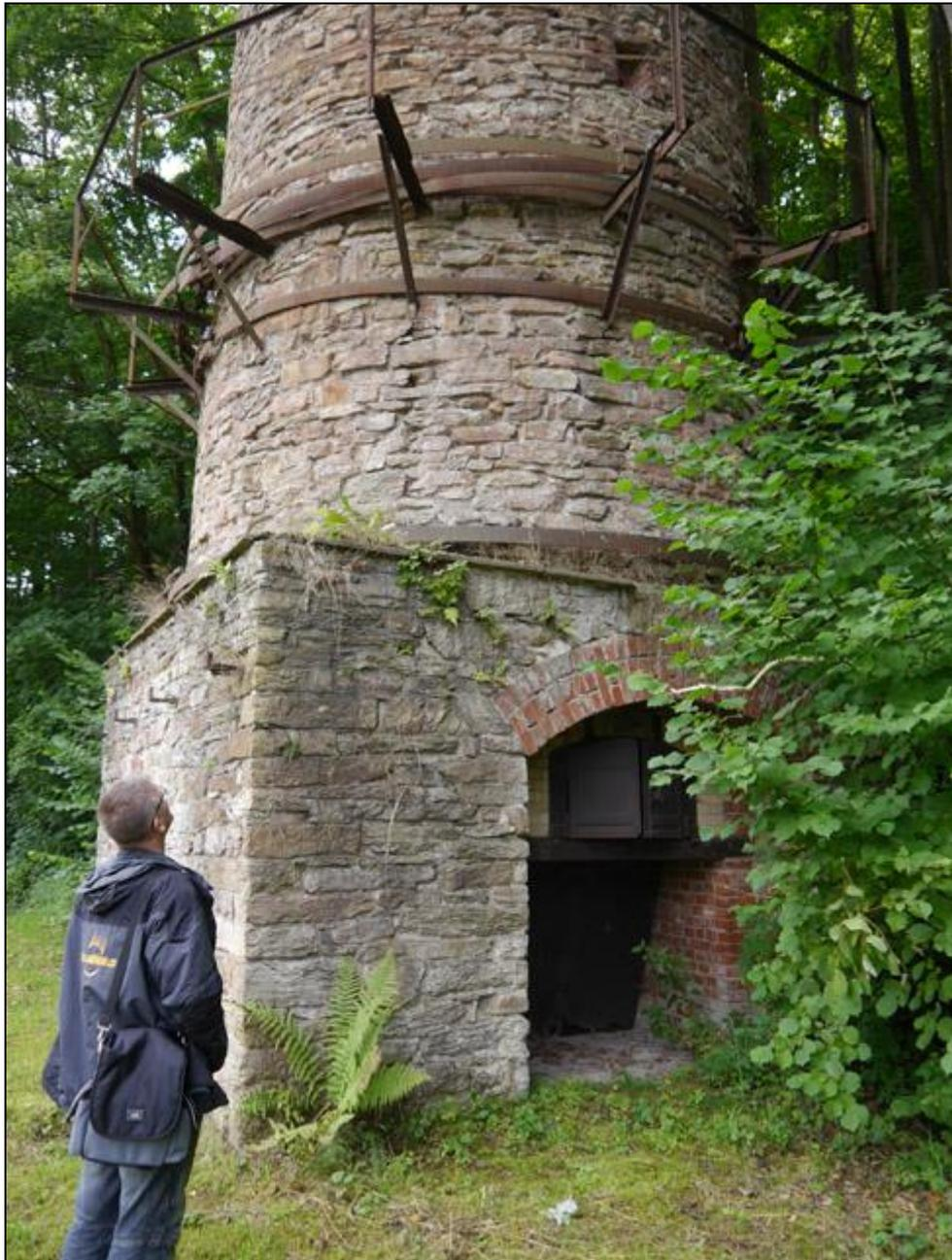
Auf dem Podest steht der eigentliche Brennofen mit quadratischem Sockel. Von hier aus sind die beiden Abzüge für den Stückkalk zugänglich.
