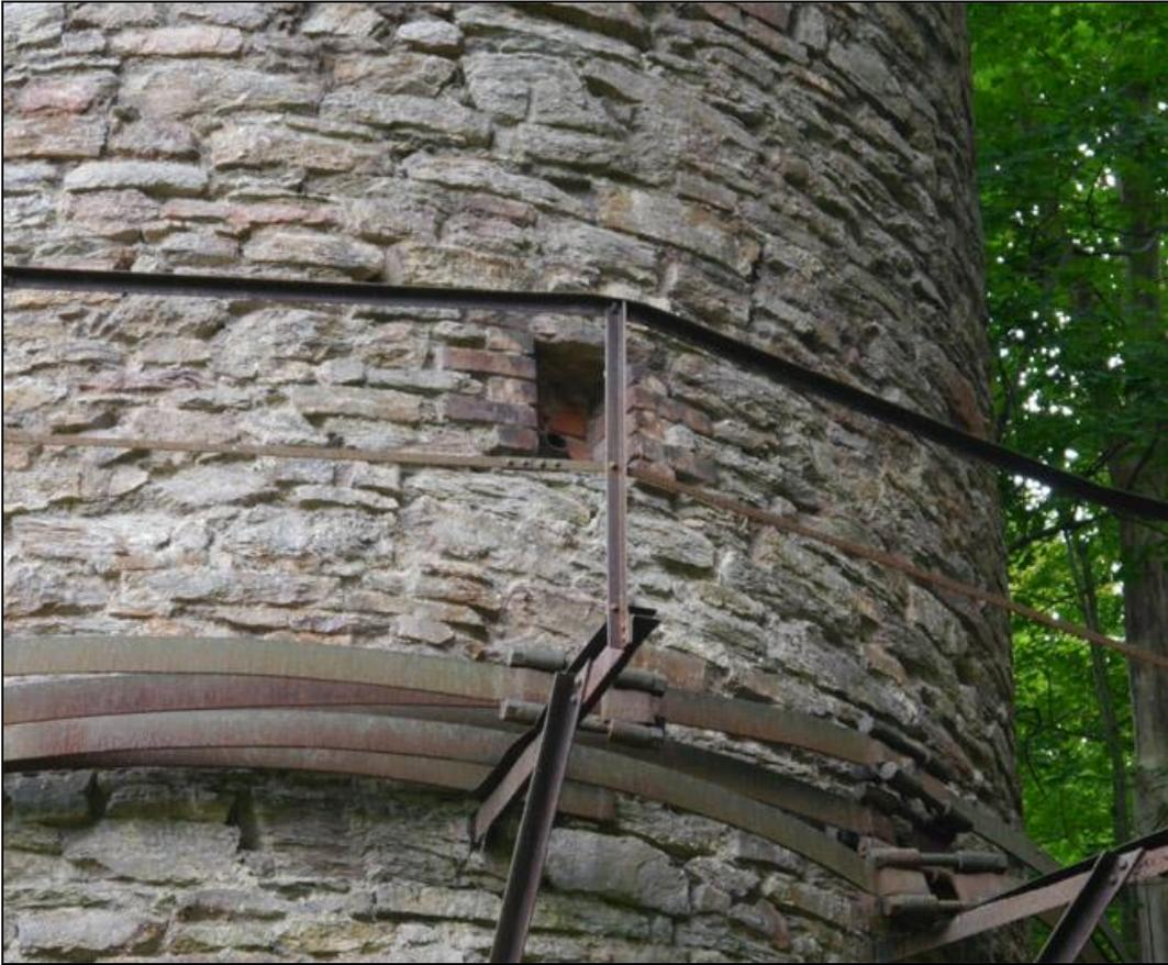
Wenn man genau hinschaut, erkennt man noch Rohrstützen in den Windöffnungen im Niveau der Arbeitsbühne.
