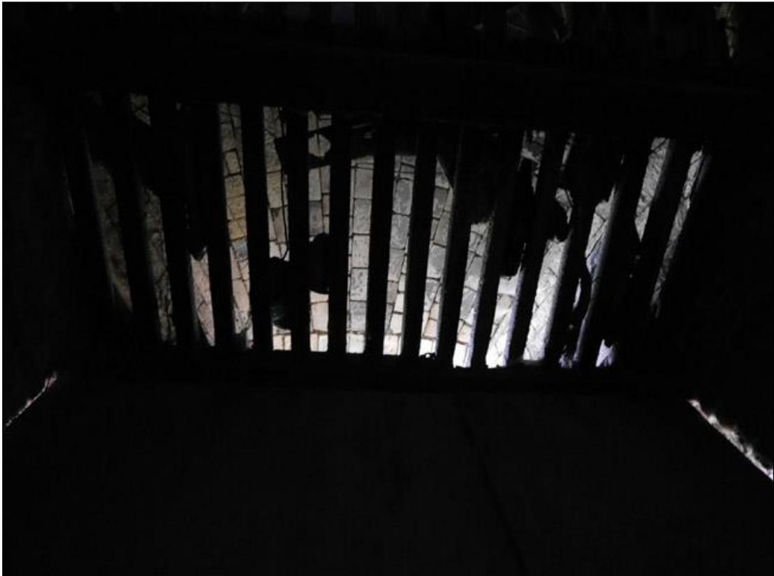
Von unten erkennt man nur die Gewölbe der Zugänge oberhalb der Roste. Der Stückkalk rutschte auf diesen keilförmig von unten in den Ofenschacht hineinragenden Gitterrosten zu den seitlich liegenden Abzügen oberhalb des Aschefalls.
