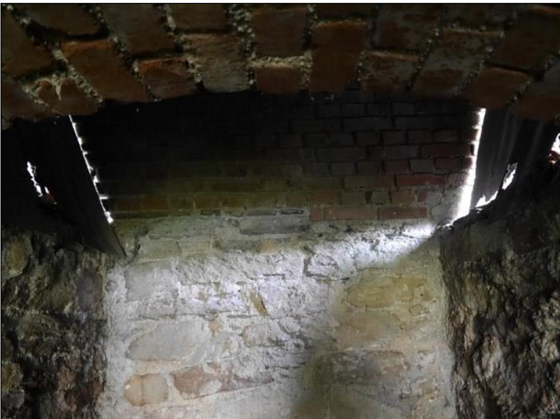
Beiderseits oberhalb befinden sich die Abzüge für den gebrannten Stückkalk. Von den Abzügen noch herabfallender Abrieb rutschte über zwei Bleche in den Aschefall.
