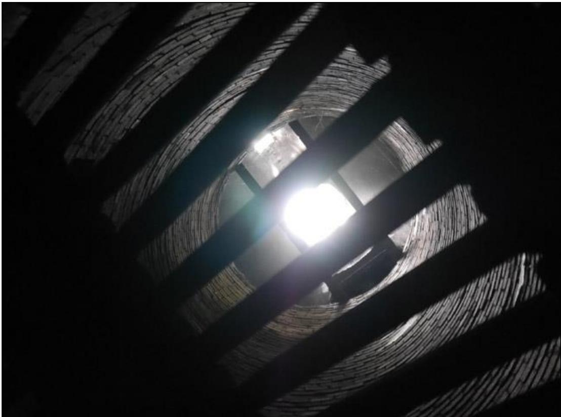
Durch die Roste hindurch kann man bis zur Gichtbühne hinauf in den zylindrischen Brennraum hineinschauen. Der Brennschacht selbst mag etwa 7 m bis 8 m Höhe bis zur Gichtbühne besitzen.
