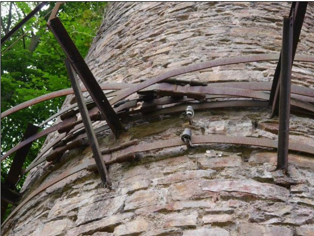
Die eisernen Reifen sollten wohl einst thermische Spannungen im Mauerwerk auffangen. Die meisten sind inzwischen lose und bis zur mittleren Arbeitsbühne hinunter gerutscht. Ansonsten sieht das Mauerwerk aber noch recht gut erhalten aus, wenn man in Betracht zieht, daß der Ofen seit 1950 still liegt. Möglicherweise diente er danach aber auch mal als Ersatz für einen Stromleitungsmast.
