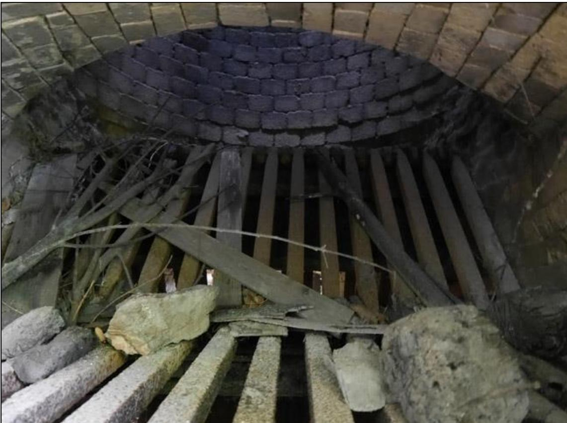
Über diese Roste rutschte der fertig gebrannte Stückkalk zu den Abzügen, während die mit Abrieb und Kalk vermischte Asche nach unten hindurch in den Aschefall fiel.
