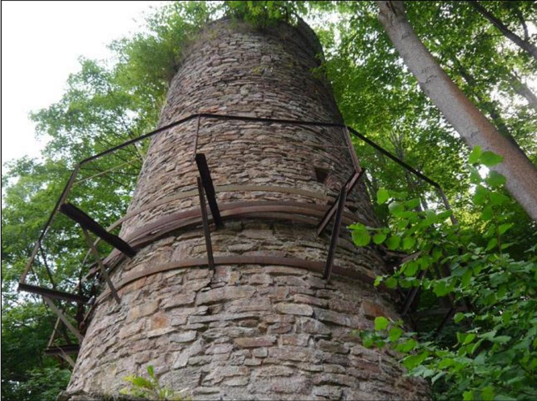
Auf Höhe der Brennzone – etwa in halber Höhe des Schachtofens – befand sich eine weitere Arbeitsbühne. Zu erkennen sind auch hier einzelne schmale Windöffnungen, über welche die Luftzufuhr und damit die Brenntemperatur kontrolliert werden konnte.
