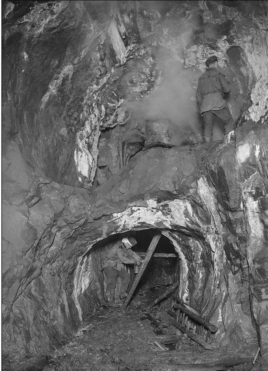
„Vereinigtes Feld im Zwitterstock“, Große Radstube mit Rösche für den Ablauf des Aufschlagwassers,
