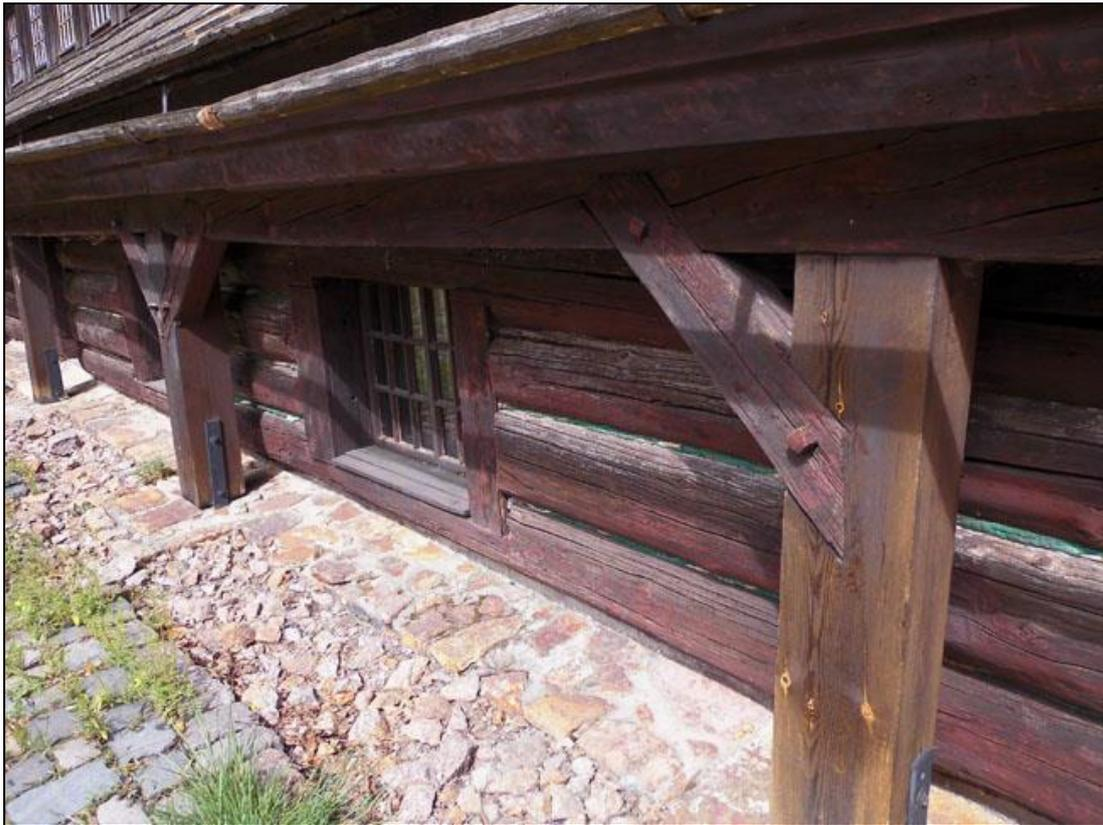
Das dicke Balkenwerk ertrug die Vibrationen besser als starres Mauerwerk. Die vorgesetzten Ständer tragen - quasi mechanisch "entkoppelt" - das Dachgeschoß.
