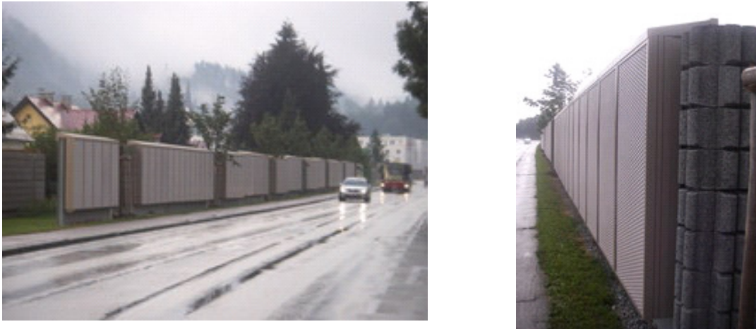
Abbildung 38: Lärmschutzwand mit integriertem Feinstaubfilter in Klagenfurt
