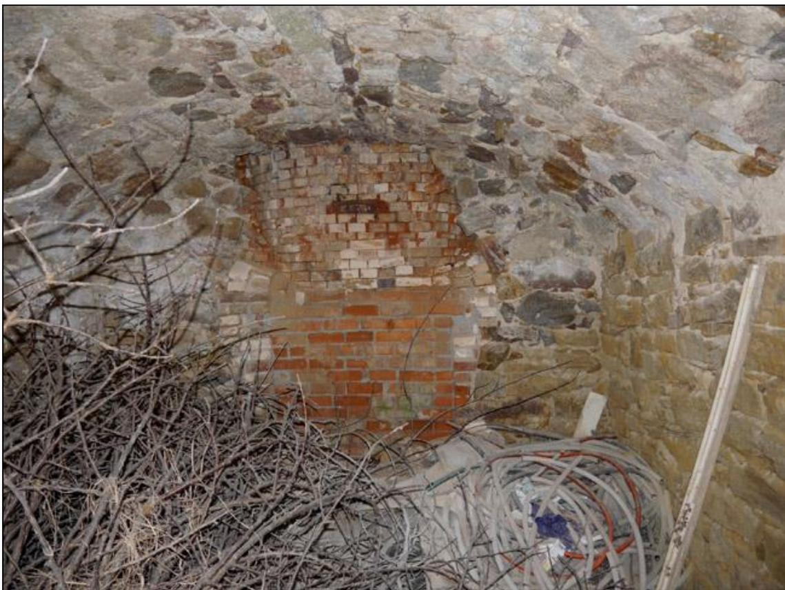
Die Abzugsöffnungen sind allerdings vermauert und die Trichter zugefüllt. In einem der Zugänge kann man hinter allerlei Gerümpel aber noch erkennen, wo sich der Brenntrichter befand.
