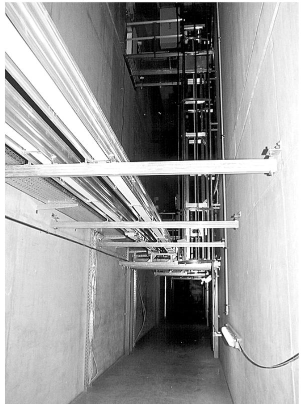
*oben: Im Schacht der Buchförderanlage sind die Wege für den horizontalen und vertikalen Transport deutlich zu erkennen.*
